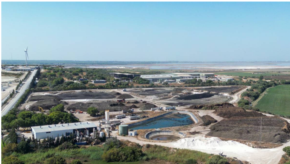
Vista del complejo medioambiental de Las Calandrias, que pronto estrenará sus obras de modernización. - JUAN CARLOS TORO
