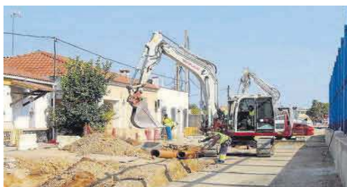
Operarios trabajan en la instalación de las nuevas tuberías de abastecimiento junto a las viviendas de la carretera de Sevilla.
